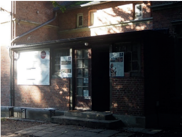
Der Eingangsbereich zur Villa während der Sanierung
