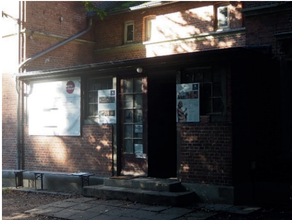
Der Eingangsbereich zur Villa während der Sanierung
